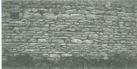
Solin maçonné en moellons de calcaire
