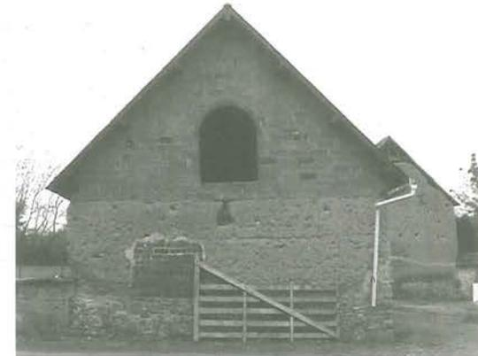
Maçonnerie avec un rehaut réalisé en briques creuses de Périers
