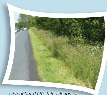
> En début d'été, talus fleuris et accotements dégagés
