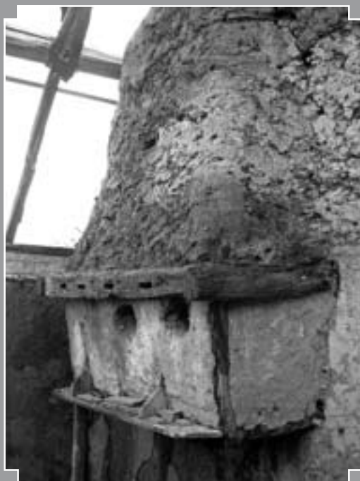
Fig. 10 : Belle-Vue à Vibraye, cheminée en terre - détruit (PAH du Perche sarthois).
