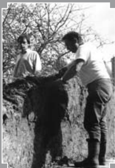
Fig. 4 : Retaille d'une levée de bauge (CAPEB Haute-Normandie).
