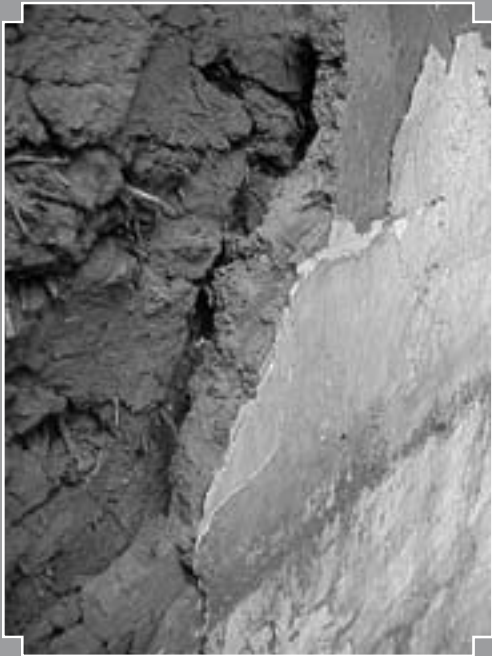
Fig. 9 : D tail des enduits sur la face int rieure d'un mur de terre d'une habitation du village de Bierghes. Sur un support o  l'on distingue la trace des pains de terre et de l'outil utilis  pour les  galiser, deux couches de terre m lang e de fines paille. La couche sup rieure est tr s soigneusement liss e (G. Bavay).
