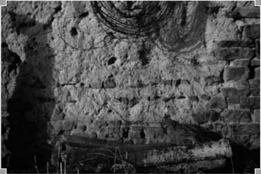
Fig. 3 : Bâtiment en bauge à Ondefontaine. Deux rangs de schiste au moins sont visibles dans la maçonnerie en terre (Service d'Archéologie du Conseil général du Calvados).
