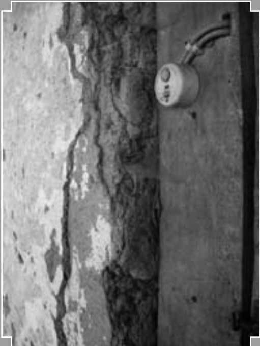
Fig. 5 : Détail des finitions en terre tamisées et chaux aux Gravelines, Le Temple-sur-Lot (H. Mousset).
