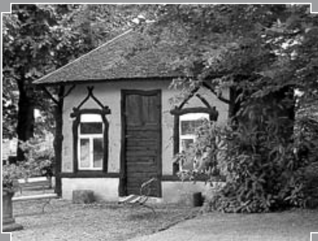
Fig. 7 : Pavillon de jardin du château de la Roche à Thieusies. Derrière un décor «savant» simplement plaqué, toute la structure est typique de l'architecture de bauge. C'est le seul bâtiment portant millésime (1908) et probablement aussi le pus récent (G. Bavay).
