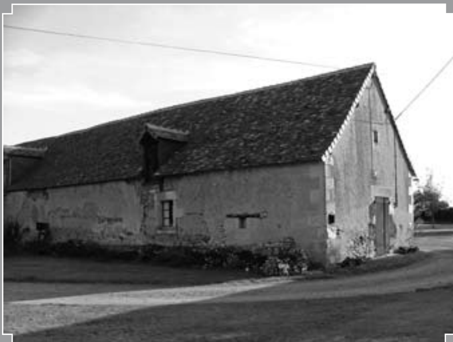
Fig. 4 : Ancien enduit chaux sur la maçonnerie en bauge d'une ferme de « la Ligne acadienne » (L. Malvido).
