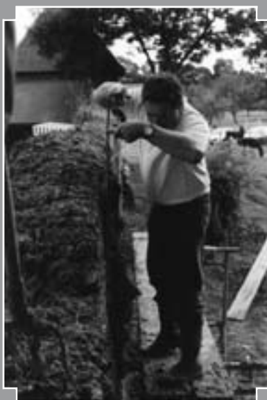
Fig. 3 : Retaille d'une levée de bauge (CAPEB Haute-Normandie).
