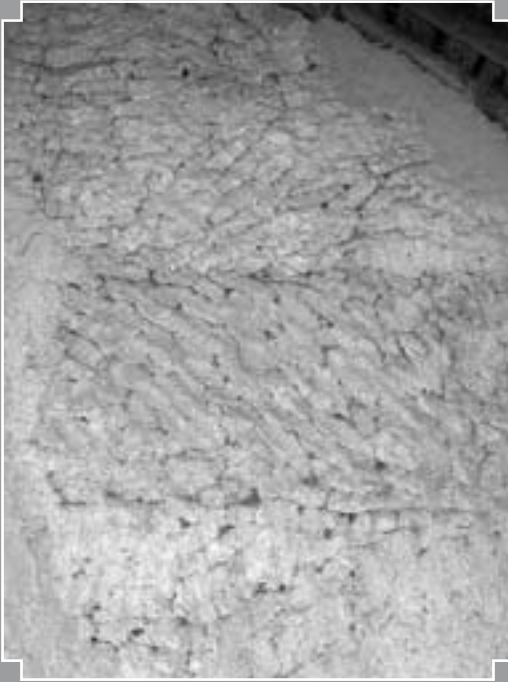
Fig. 7 : Maison du Puits Gaillard à Saint-Gilles (35) – détail du parement intérieur du pignon avec les mottes de terre modelées – début du 17 e siècle (Ph. Bardel).
