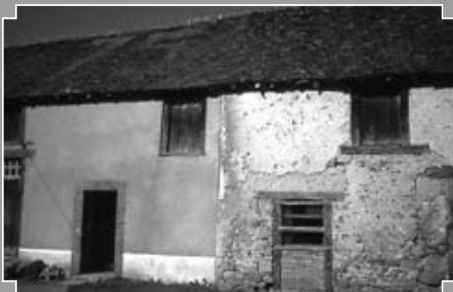
Fig. 9 : On voit ici deux états de lecture d'un même bâtiment divisé au fil des successions. A droite la construction d'origine, la bauge est lisible sous l'enduit à la chaux dégradé. A gauche, un encadrement en bois a été remplacé par de la brique et la façade a été entièrement cimentée, Le Peu, Tilly (Dany Chiappero / Pnr Brenne).
