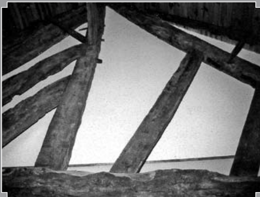
Fig. 8 : Bédée, la Giraudais, ancienne ferme de tête avec contre-fiche en remploi en contreventement longitudinale (A. Le Meur).
