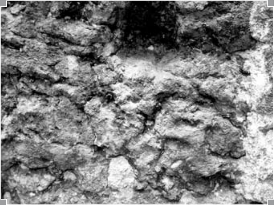
Fig. 9 : Montagnac (Hérault) : détail de mottes de bauge sur un parement non redressé, 14 e s. (C.-A. de Chazelles).
