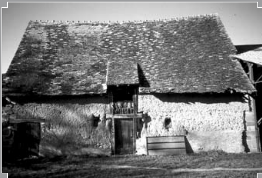
Fig. 5 : Grange bergerie datée par dendrochronologie de 1846. Le mur en bauge est construit en avant de la structure sur poteaux de la grange, Le Gué Martin, Tilly (Dany Chiappero / Pnr Brenne).
