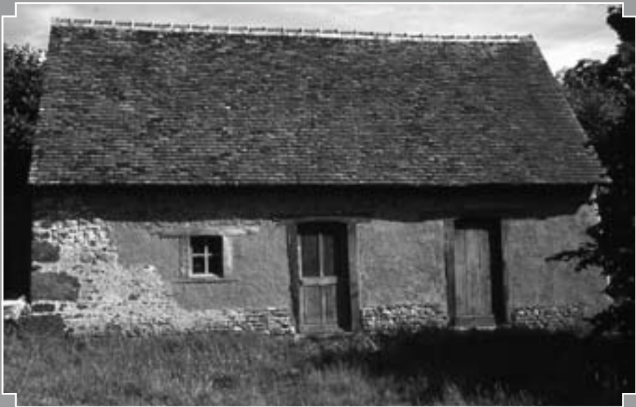
Fig. 4 : Maison « au lierre », construite entièrement en bauge sauf le pignon sur lequel s'appuie la cheminée. Le mur bahut remonte pour former une sorte de berceau aux angles, Le Peu, Tilly (Dany Chiappero / Pnr Brenne).
