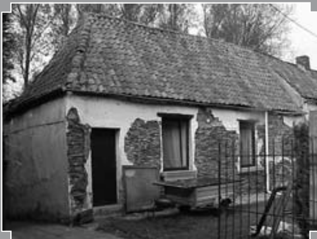
Fig. 3 : Petite habitation rurale à Braine-le-Comte. Un enduit cimenté a masqué des moellons et de la bauge. La bauge se cantonne au niveau de la réserve de grain sous le débordement de la toiture. La croupe très relevée rappelle les modèles en terre et chaume (G. Bavay).
