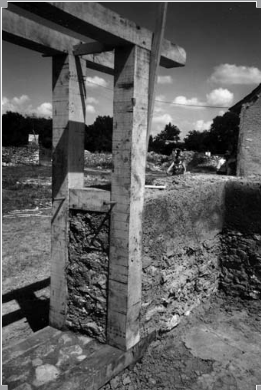
Fig. 3 : Carrée double, soubassement et levée de bauge (L. Malvido).
