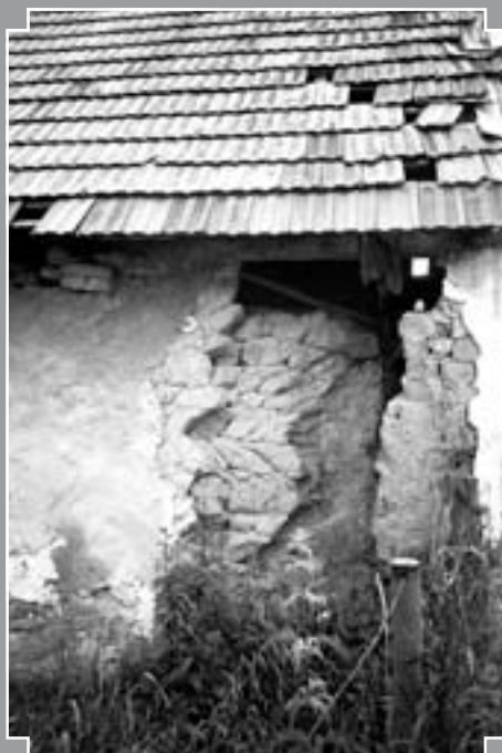
Fig. 10 : Détail du mur en construction mixte en války (rouleaux ou mottes de terre) banchés appareillés en épi et briques crues à Pernek, Slovaquie (Z. Syrová 1995).
