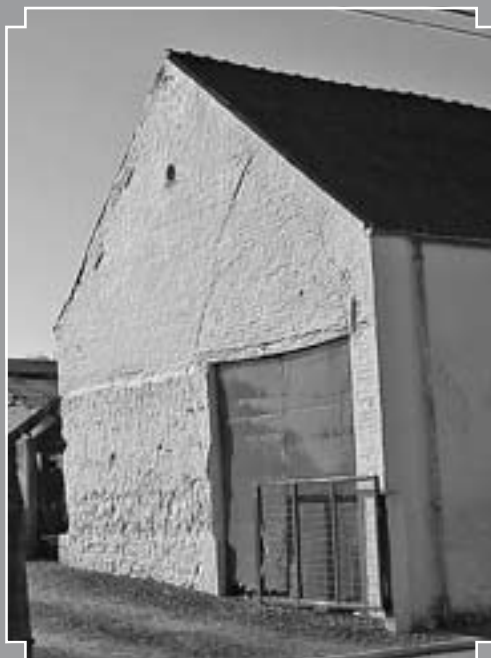
Fig. 5 : Grange au village de Naast. Sous le badi-geon, la grange est restée « invisible » longtemps. L'œil découvre aujourd'hui une grange en bauge rehaussée en brique tant au pignon que sur les murs latéraux (G. Bavay).
