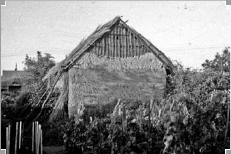
Fig. 4 : Pressoir à vin en bauge montée à la fourche avec le pignon tressé partiellement couvert de torchis à Dolný Peter, Slovaquie (Z. Syrová 1990).
