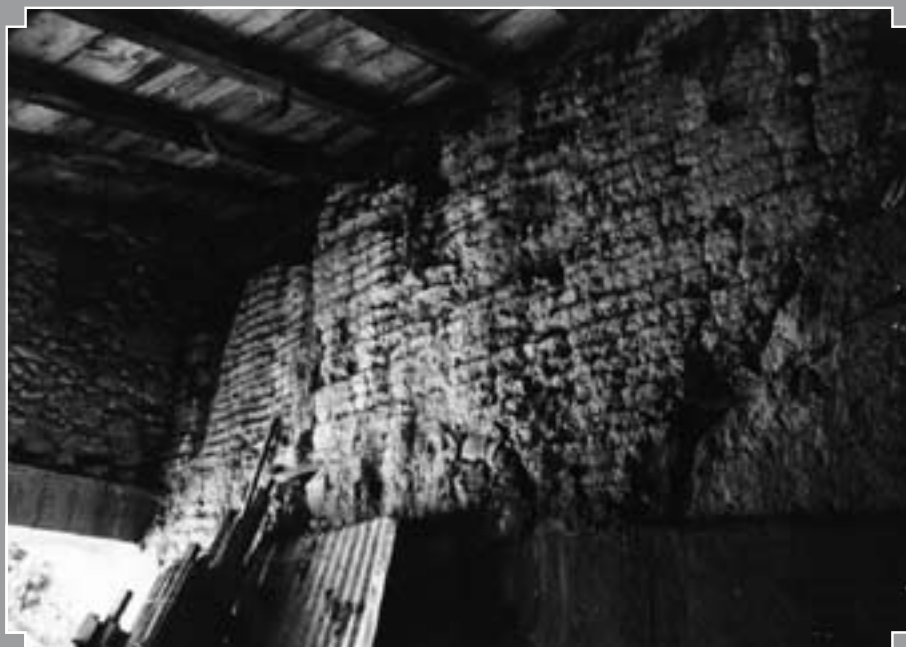
Fig. 3 : Construction en couches continues au sud du département, à Lagroué, Francescas (H. Mousset / SRI Aquitaine)
