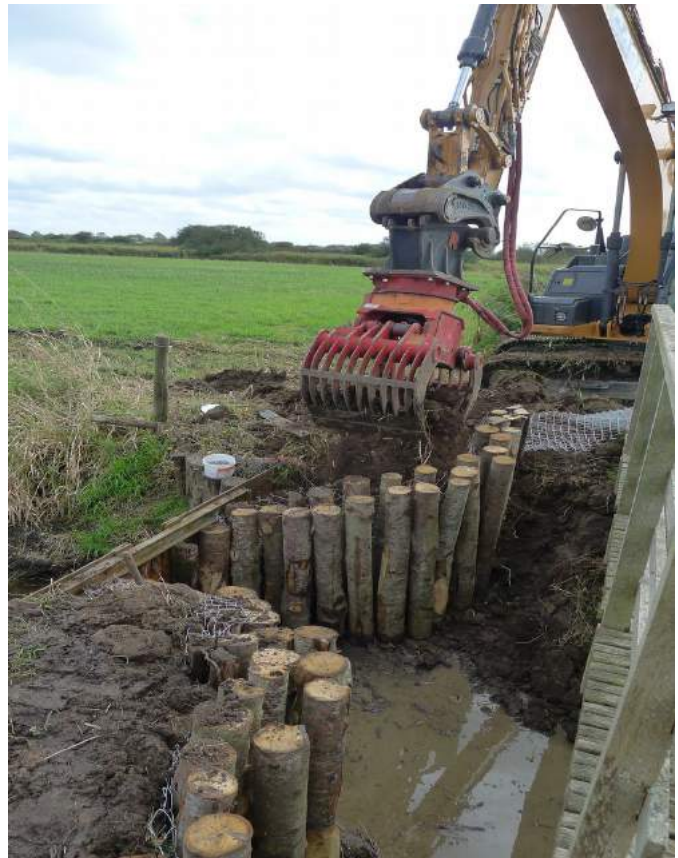
Restauration d'un ouvrage hydraulique – ENS marais des ponts d'Ouve
