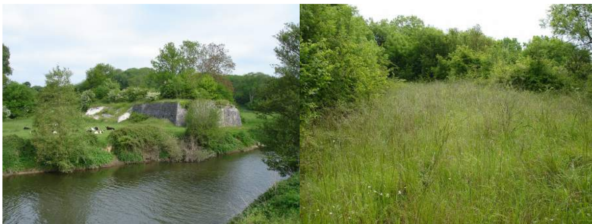
pelouses calcicoles suivies : pile du pont et toit des fours de la Roque-Genest
