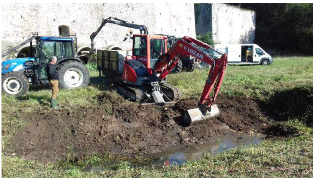
Terrassement des berges – Hamel Bazire
