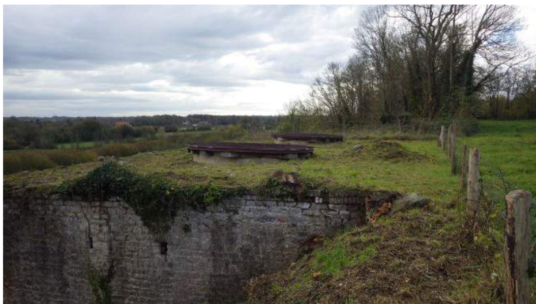
Toiture des fours du Hamel Bazire
