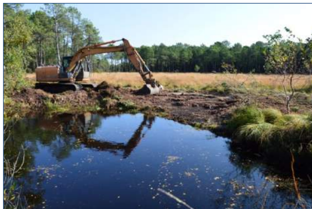
Octobre 2021 – pendant travaux d'étrépages / reprofilage © ONF
