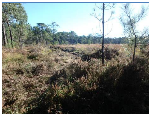
Octobre 2021 – pendant les travaux de coupe
