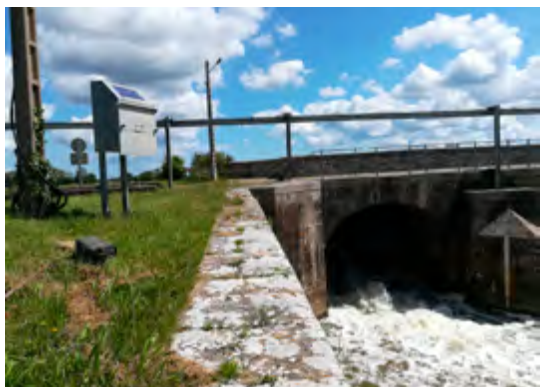
Le Pont de la Barquette à Carentan-les-Marais (Saint-Côme-du-Mont, 50)
