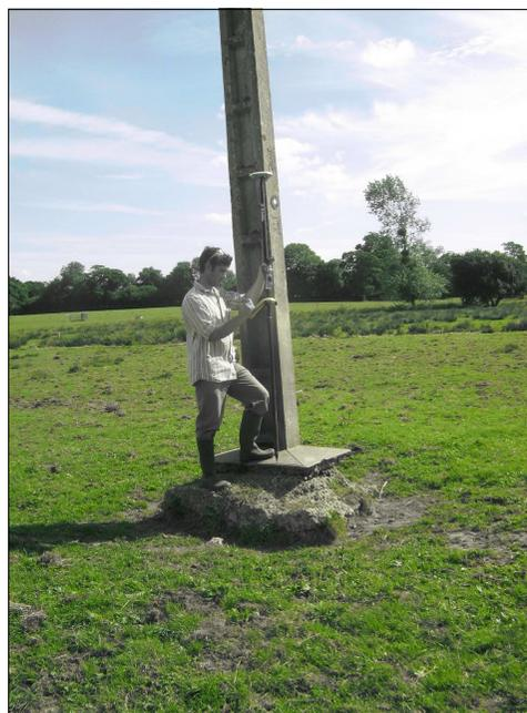
Descellement d'un pylône suite à l'affaissement du sol
