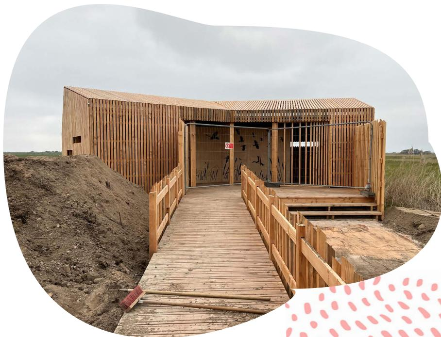
Quant aux cheminements, l'essentiel du tracé est réalisé, ainsi que la totalité des infrastructures (platelages, passerelles). Les raccordements de clôtures, l'étanchéité des anciens observatoires et la pose de barrières ont été réalisés. Une réflexion est en cours pour trouver une solution pérenne au problème de stationnement.
