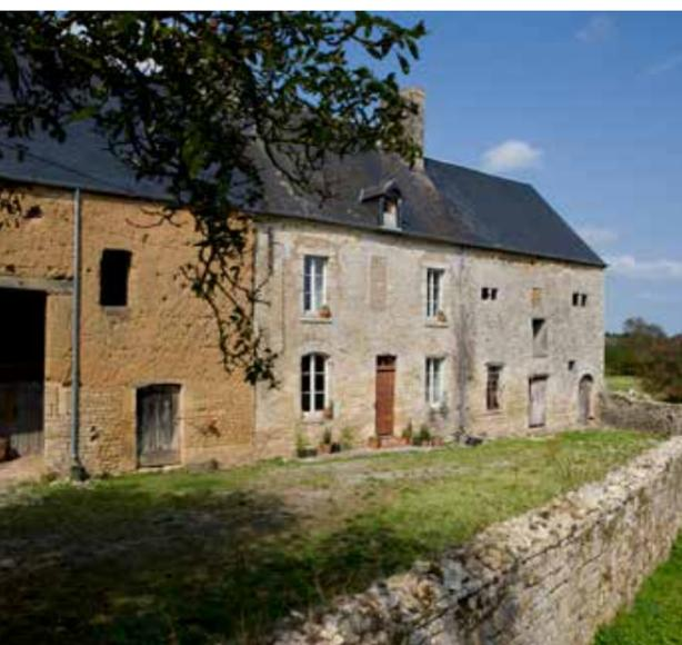
nouvelles constructions. La bauge, mélange de terre crue et de fibre végétale, est une technique de construction caractéristique des marais du Cotentin et du Bessin. Localement, elle est appelée de plusieurs manières : "mur de terre", "masse", "massé", "torchis" ou "mur d'argile". Le territoire du Parc compte environ 10 000 constructions bâties avec cet éco-matériau, dont les plus anciennes datent du XVI<sup>e</sup> siècle.
