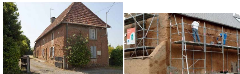
Photo 18 - Bâti en bauge et chantier de rénovation de façade. Source : F. Streiff - PnrMCB
