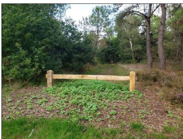
Pose barrière forestière – lande de Millières (STEVE)
