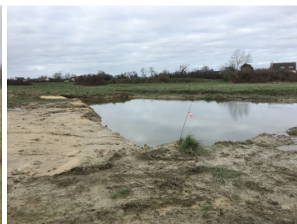
Après les travaux – 16/02/24
