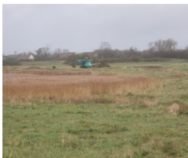
Pendant les travaux 06/11/23
