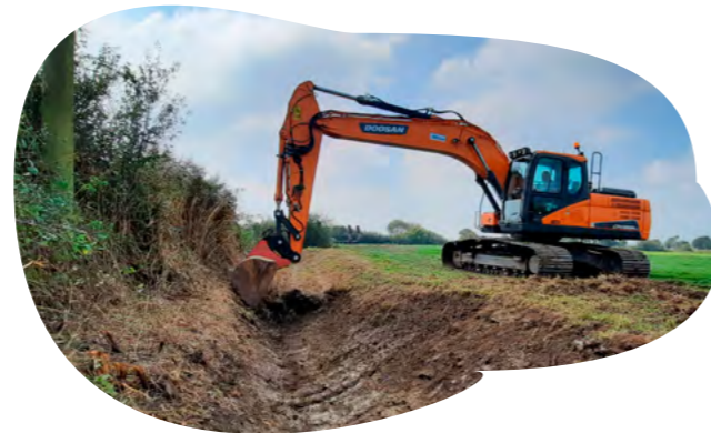
Remise en état de fossés - E.N.S. des Marais des Ponts d'Ouve - Carentan-les-Marais
