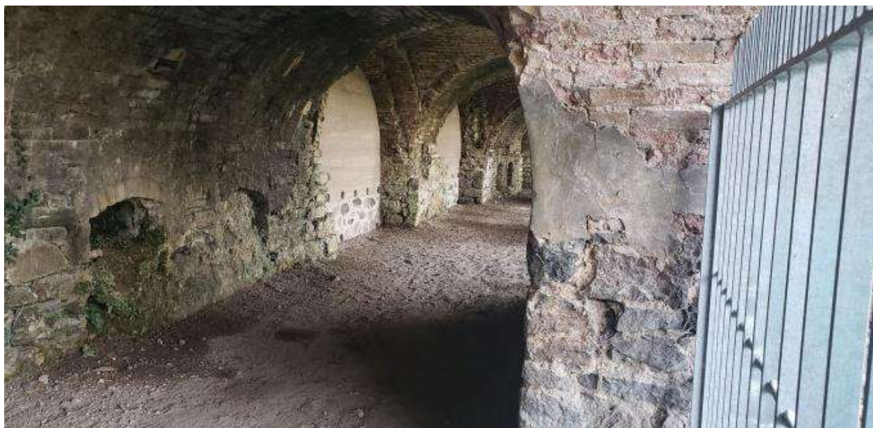
Mise en défens des alvéoles du Hamel Bazire par la pose de grilles et de murs en bauge © N. Simon
