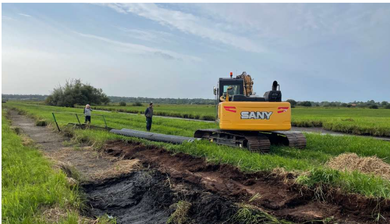
Remplacement d'un ouvrage à batardeau défectueux sur Pénême par une buse à clapet © J.-M. Savigny
