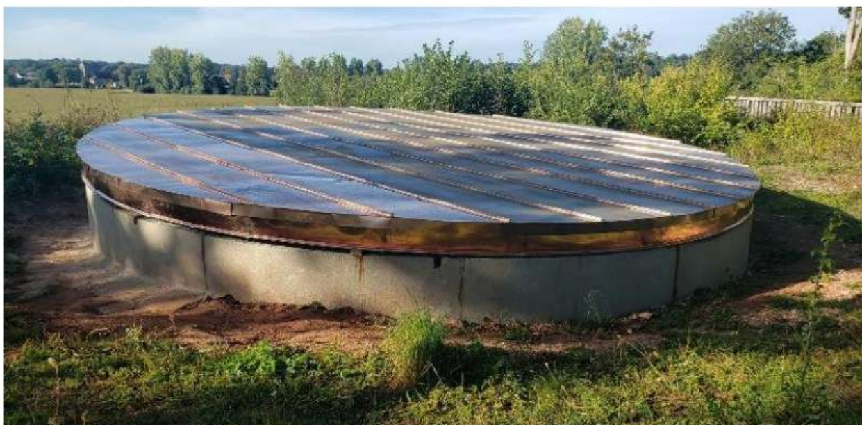
Couverture en cuivre sur le haut du gueulard nord-ouest du four de Bahais © N. Simon
