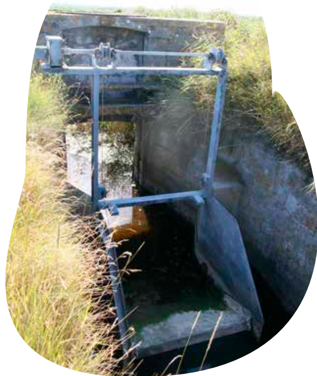
Ouvrage hydraulique de la côte Est du Cotentin
