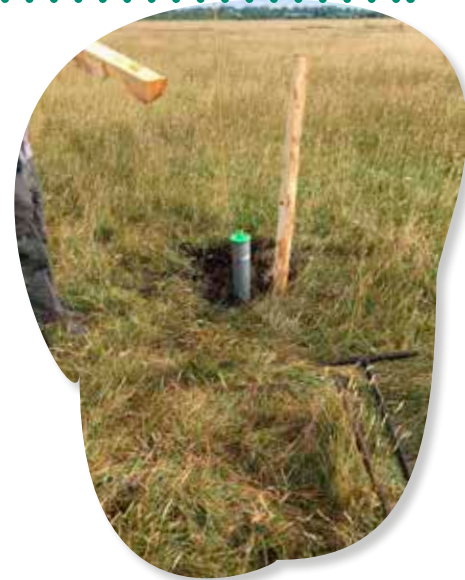
Pose d'un piézomètre
