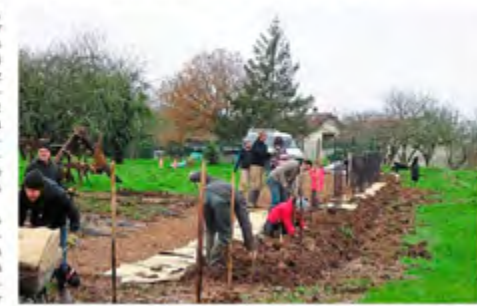
Un chantier très actif sous les conseils avisés du pépiniériste Jean-Luc Lefèvre. (Photo: Ouest-France)
